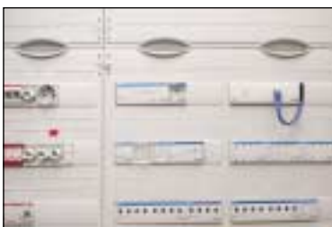
Verteiler mit EIB/KNX-REG-Komponenten von Busch-Jaeger und dem LAN-Gateway von b.a.b.-Technologie.
