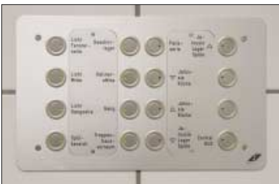
Ideal für die Hotelküche, da robust, pflegeleicht und eindeutig in der Bedienung, ist das Gepro EIB-Tableau 16-fach.
