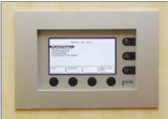
Zugriff auf Lichtszenen, Dimmwerte usw. hat man vor Ort mit dem LCD-Tableau von Busch-Jaeger.
