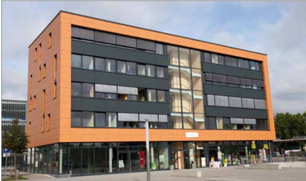
In diesem Geschäftshaus in Hennef wurde der eibPort als Bindeglied von EnOcean und KNX bereits installiert
