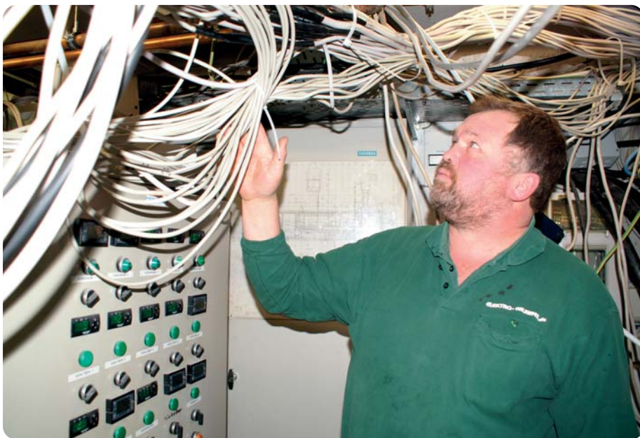
Die gesamte Elektroinstallation musste nach einem Brand erneuert werden – Stück für Stück in unzähligen Nachtschichten. Hier Jörn-Erik Tesmann von Elektro Wilkens bei der Arbeit.
